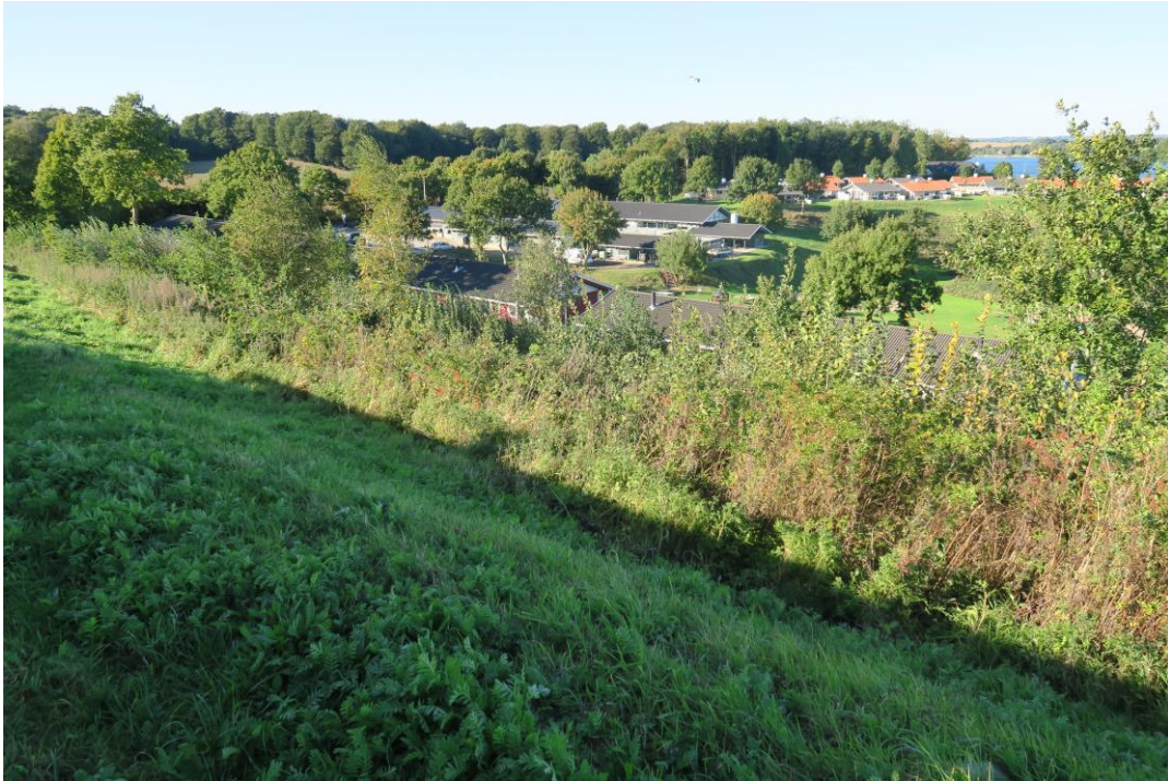
Opvækst på skråningen skjuler terrasser 11-12 meter længere nede, men hindrer også solen i at nå ned. 4. okt. 2016
